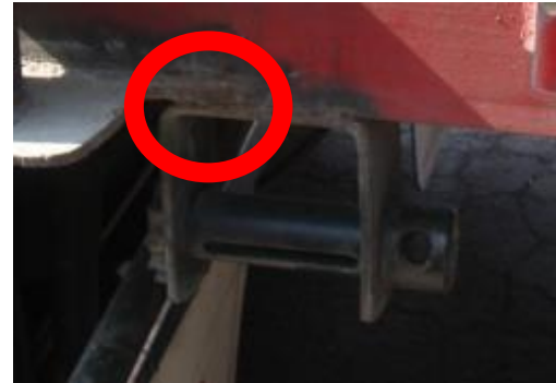
(Soldadura Mal Aplicada)
